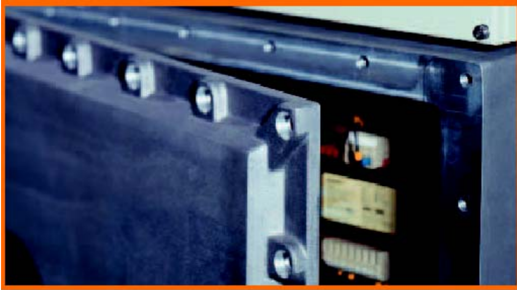
Resim 4: d-tipi muhafaza FLANŞ örneği R.Stahl firmasından alınmıştır. www.stahl.de
